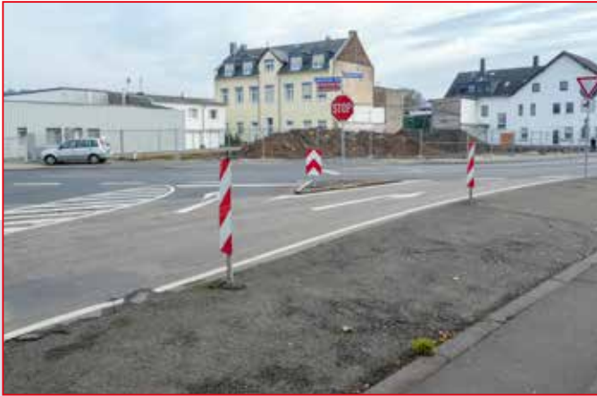
Blick auf die Kreuzung Wallersheimerweg/ Andernacher Straße
